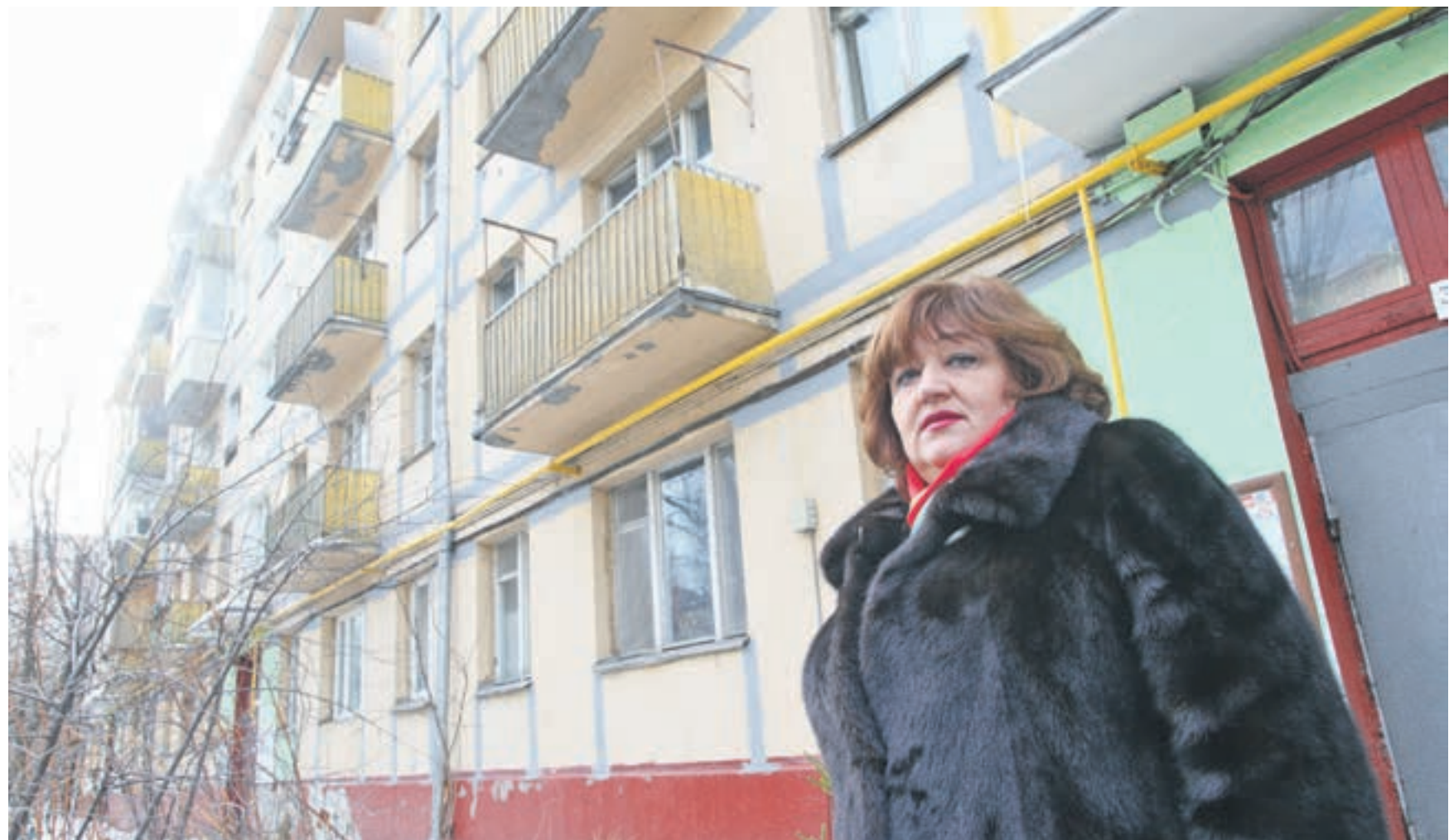
Вчера 14:58 Муниципальный депутат района Кузьминки Татьяна Рабешко у старой пятиэтажки по адресу: ул. Юных Ленинцев, 28/35. Дом в городскую программу по сносу ветхого жилья не попал, хотя свой век давно отжил
