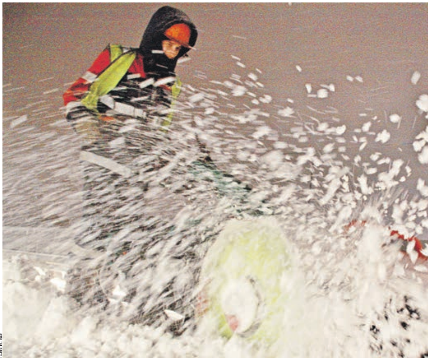
Вчера 21:55 Рабочий Эмиль Нагимов занят очисткой уникальной конструкции в парке «Зарядье» — Парящего моста. Это сооружение чистили от снега вручную — с помощью специальных щеток и пластиковых лопат
