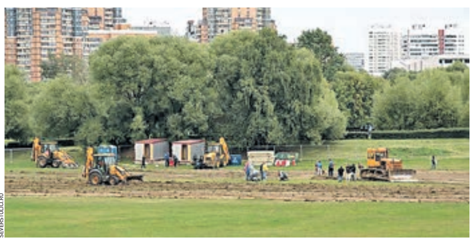
19 августа 15:30 В парке «Дружба» на севере столицы начала работать строительная техника — здесь появится современное футбольное поле с подогревом
