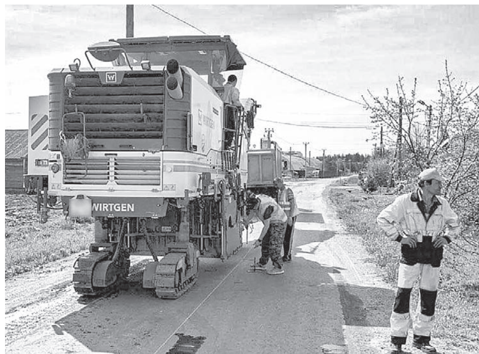
Ремонт сельских дорог.
