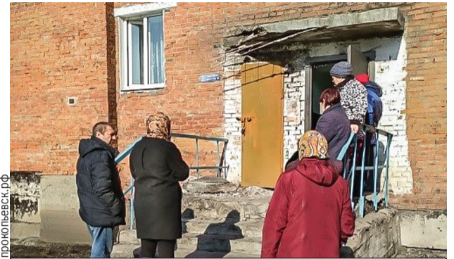
Четырехэтажное здание было построено в 1988 году.
