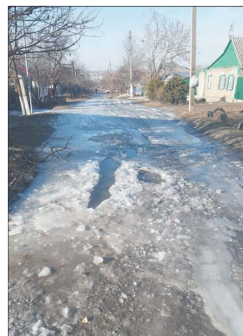
Ледяные торосы образовались во многих районах города из-за порывов водопровода. Фото читателей.
