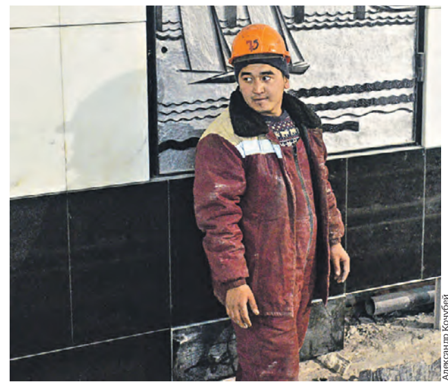
12 марта 2022 года. Выход Турсунов на строящейся станции Большой кольцевой линии «Варшавская»
