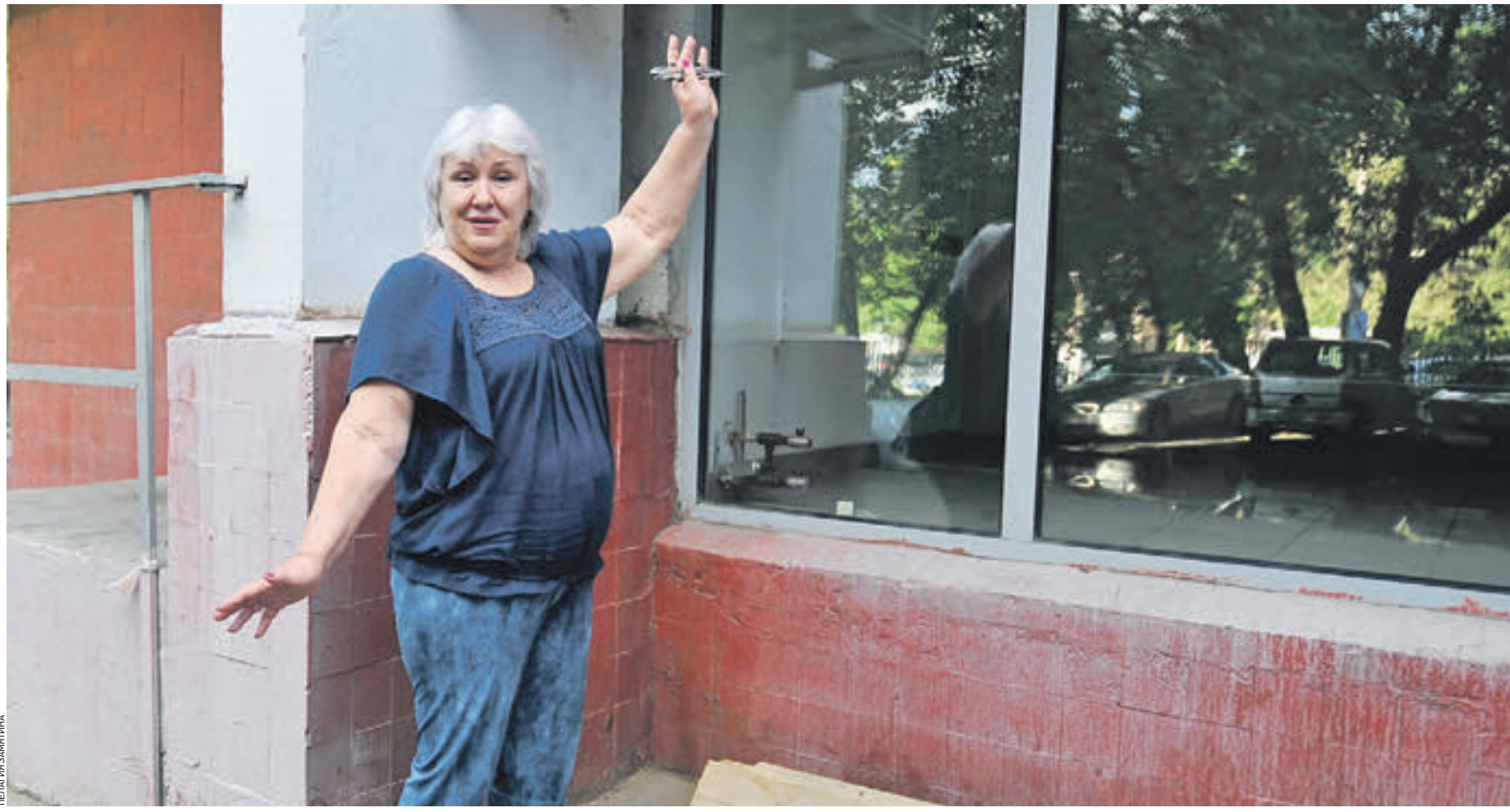
27 августа 16:00. Проспект Андропова, 21. Наталья Присяжнюк показывает окно бывшего мясного отдела гастронома, расположенного в ее доме. Отсюда долгое время доносились шумы, не дающие им с супругом спокойно спать. Ныне мясной отдел съехал, и супруги пока живут спокойно, но держат ситуацию на контроле
