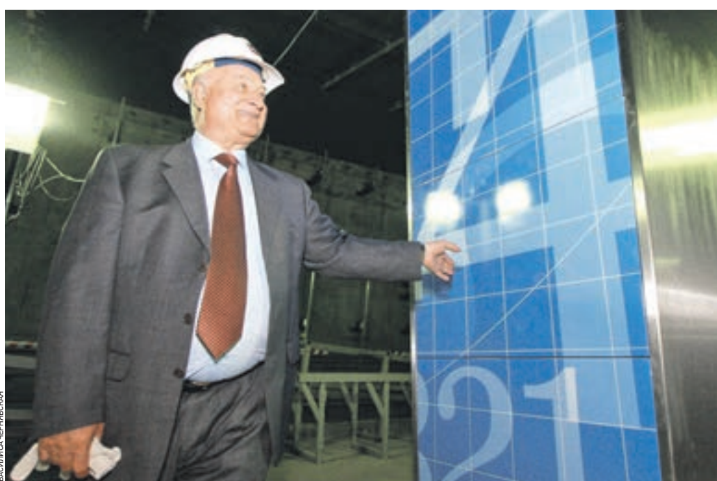
Вчера 08:30 Первый заместитель руководителя Департамента строительства Москвы Петр Аксенов осматривает готовность станции метро «Ломоносовский проспект», рабочие здесь приступили к отделке колонн
