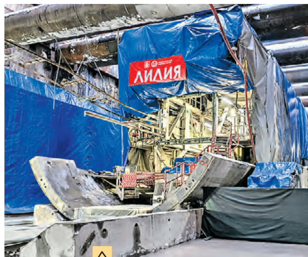
Щит-гигант «Лилия» начал проходку двухпутного тоннеля на участке Рублево-Архангельской линии метрополитена
