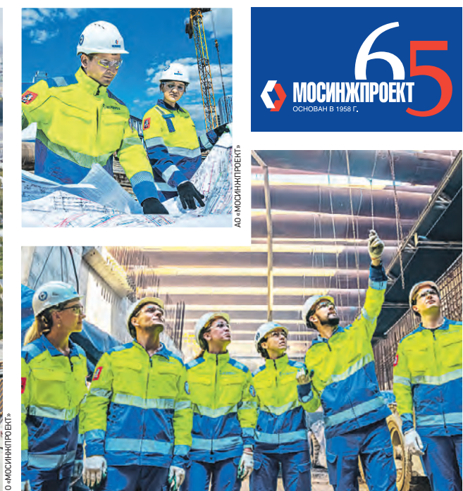
Сотрудники «Мосинжпроекта» контролируют ход работ на строящейся станции столичного метрополитена
