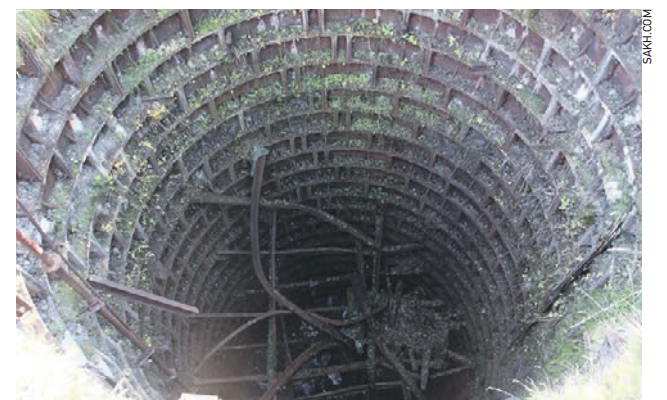
Ствол шахты на мысе Лазарева. С нее начиналось строительство Сахалинского тоннеля
