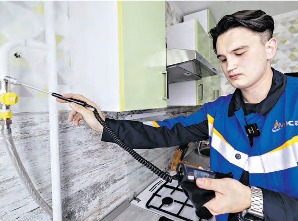
19 января. Слесарь по эксплуатации и ремонту газового оборудования АО «Мосгаз» Сергей Эпштейн проверяет герметичность соединений элементов газопровода в московской квартире
