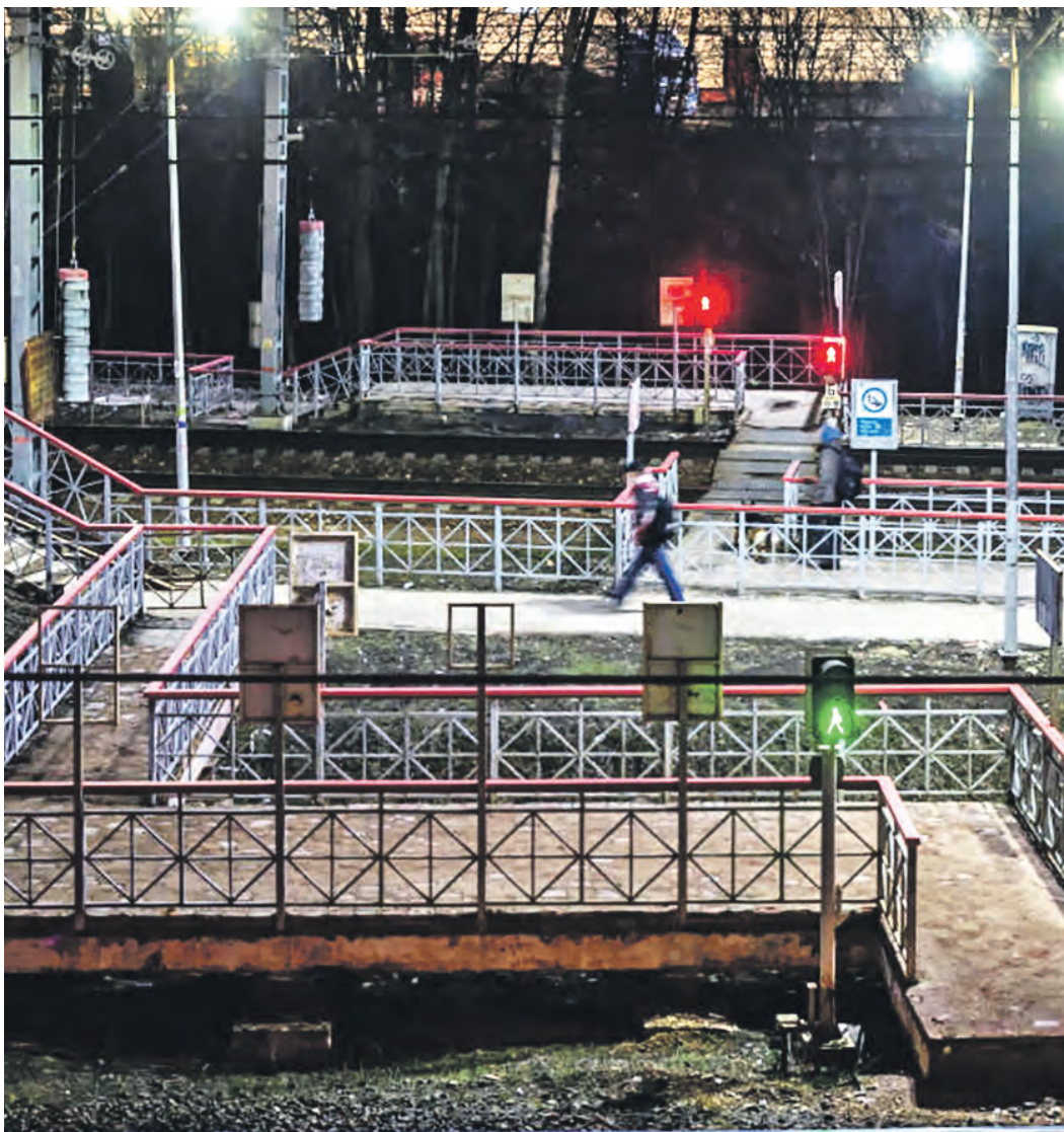
Современные пешеходные переходы на МЖД оборудованы накопительными площадками, которые дают пешеходу возможность остановиться и убедиться в отсутствии поезда
