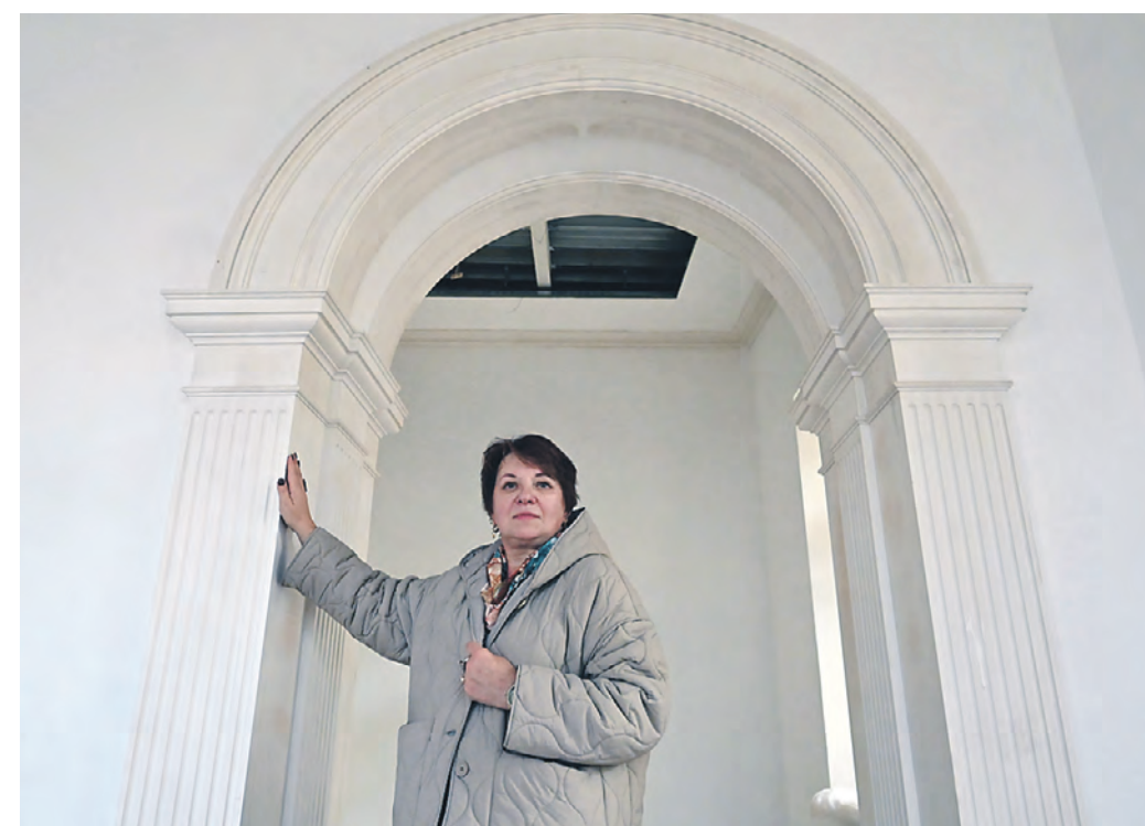
22 октября. Главный инженер проекта реставрации особняка на Тверском бульваре Нина Кононенко показала восстановленную арку в интерьере дома. Фото: Екатерина Хорошилова
