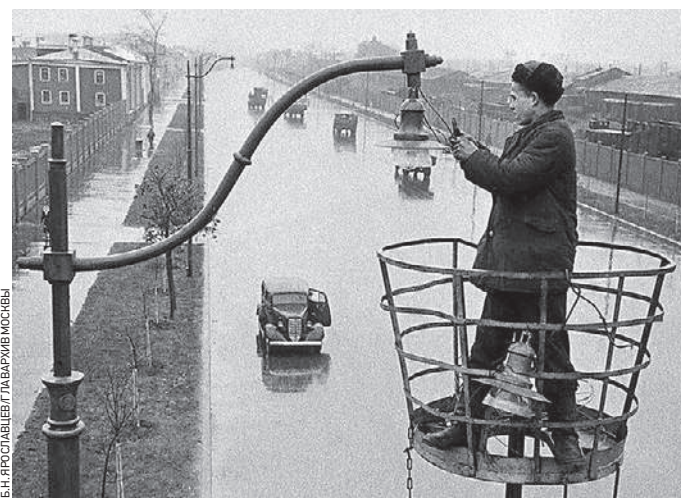
На Рязанском проспекте устанавливают фонари. Мастер крепит светильники к фигурным колоннам. Фото 1947 года
