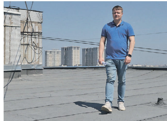
25 июля. Руководитель производственно-технического отдела ГБУ «Жилищник района Орехово-Борисово Южное» Артем Алаев осматривает отремонтированную кровлю крыши дома на Каширском шоссе. Фото: Анатолий Цымбалюк
