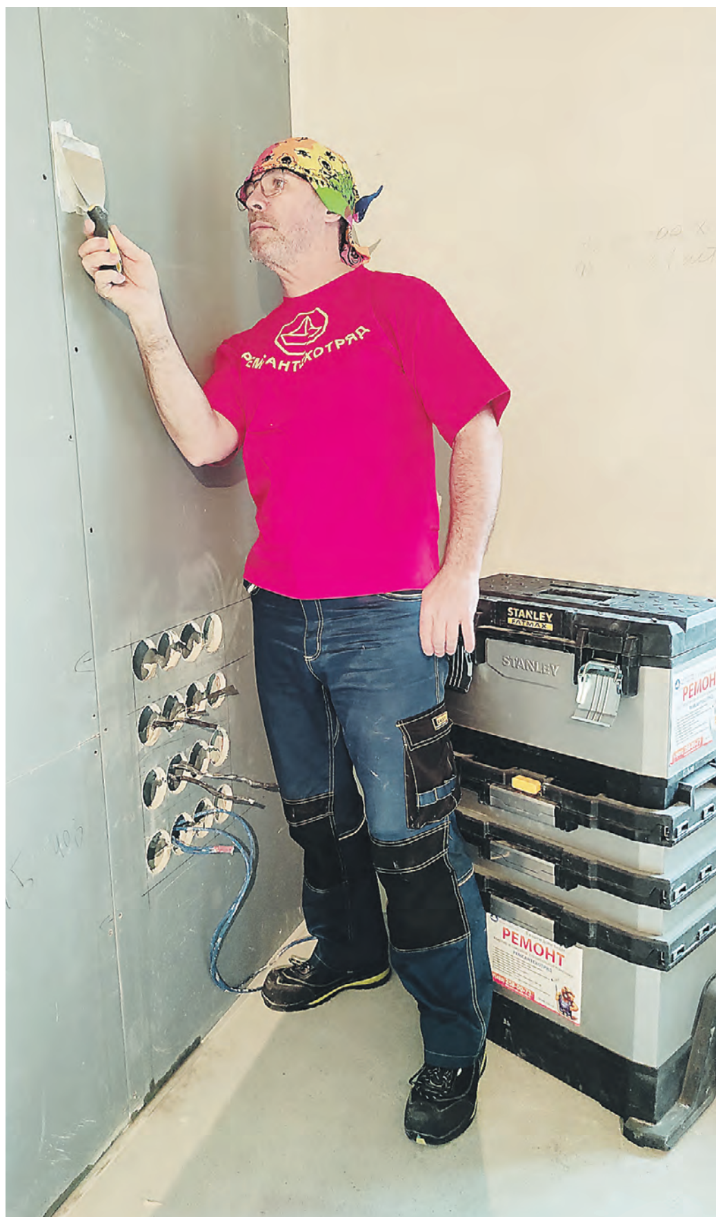
30 марта. Маляр-отделочник Петр Ростокин готовит стены под покраску. Чтобы краска легла правильно, важно убрать любые неровности, исправить малейшие недостатки
