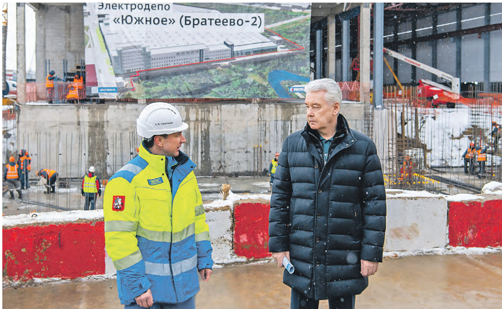
Вчера 13:30 Мэр Москвы Сергей Собянин (справа) и генеральный директор компании «МИП-Строй № 1» Константин Маслаков во время осмотра строительства электродепо «Южное» Замоскворецкой линии метро
