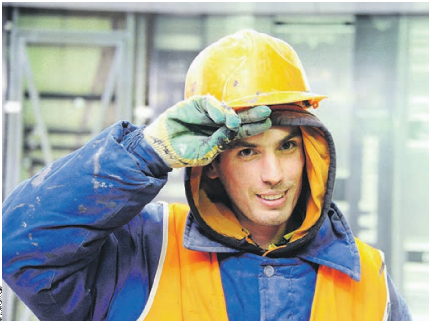
Вчера 16:10 Рабочий Александр Бондарчук отвлекся от работы и поприветствовал школьников, пришедших на экскурсию. Александр монтирует кабели на станции метро «Расказовка», работает на объекте с самого начала, как только был вырыт котлован
