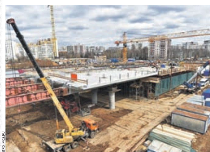
Вчера 11:47 Эстакаду возводят с двух сторон одновременно, а соединения проведут над железной дорогой
