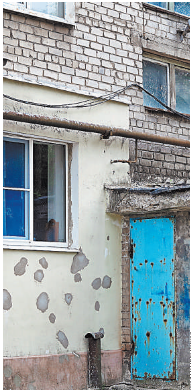
Дом на Кремлевском строили сами шахтеры — с огромным запасом прочности.
