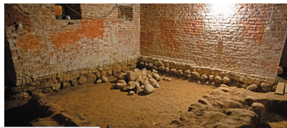
Обнаруженный во время реставрации фундамент в помещении цокольного этажа усадебного дома, 2022 год.
