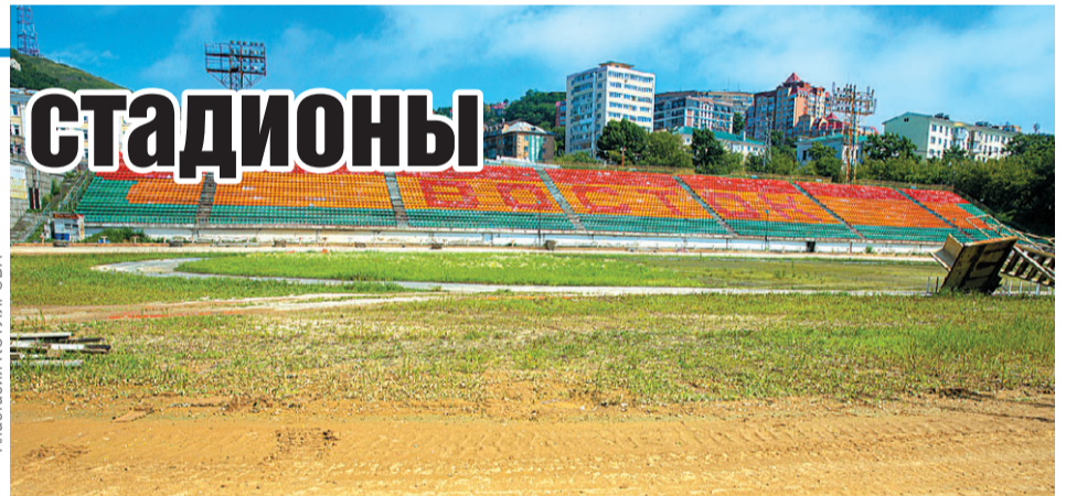
После окончания первого этапа реконструкции «Авангарда» специалисты сразу начнут подготовку ко второму.
