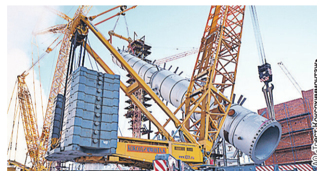
Площадка строительства «Аммиак-4». Великий Новгород, ОАО «Акрон».
