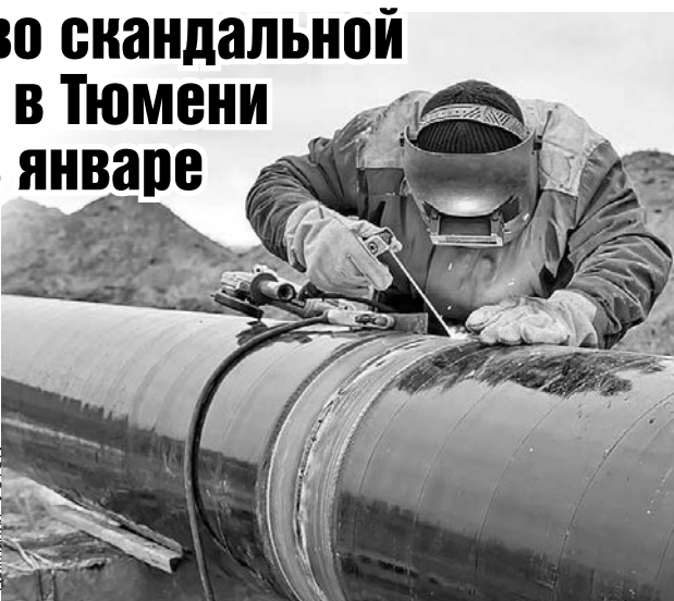
Теплотрассу продолжают прокладывать в новом году.
