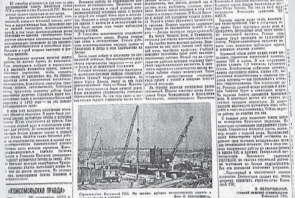
Строительство Каховской ГЭС. На снимке: бетонный завод и котлован шлюза.
