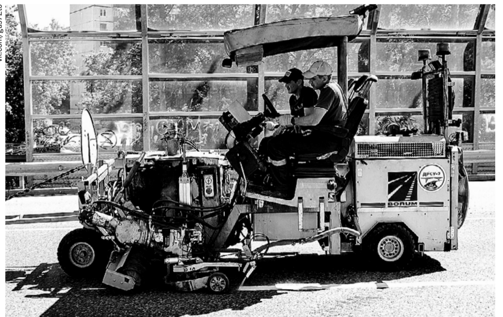
Ремонт дорог в регионе идет с опережением сроков: часть объектов уже готовится к сдаче.
