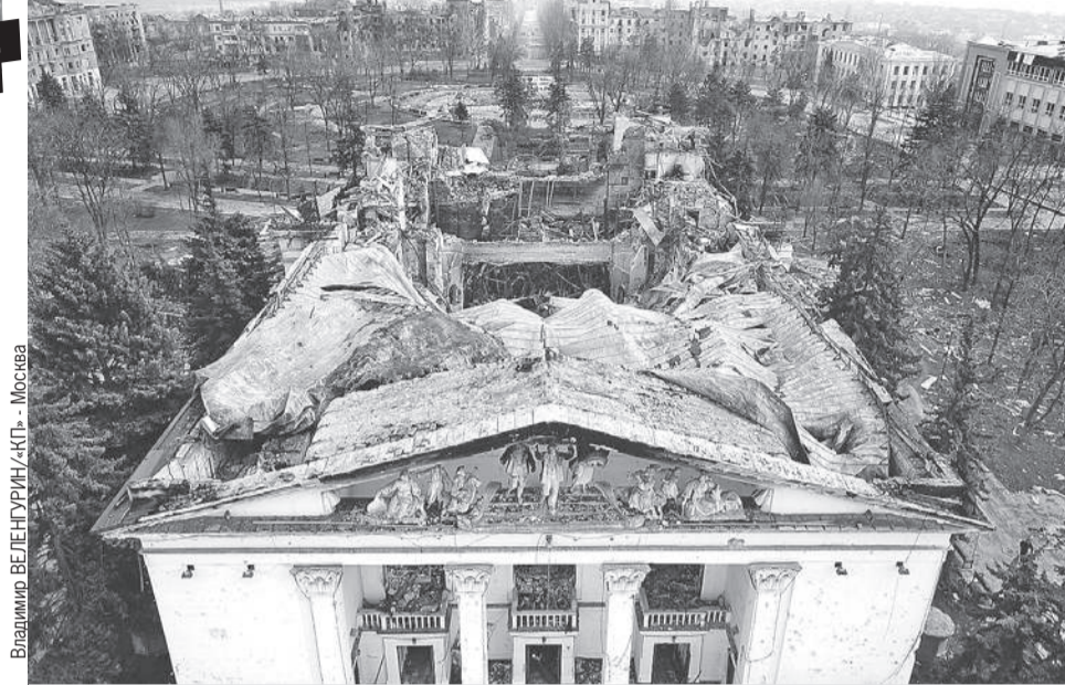
У Мариупольского драмтеатра после подрыва изнутри в 2022-м сложилась крыша, но стены устояли. Люди в подвале остались живы. Теперь Украина хочет повторить свой «трюк» - уже в детском саду или в больнице.
