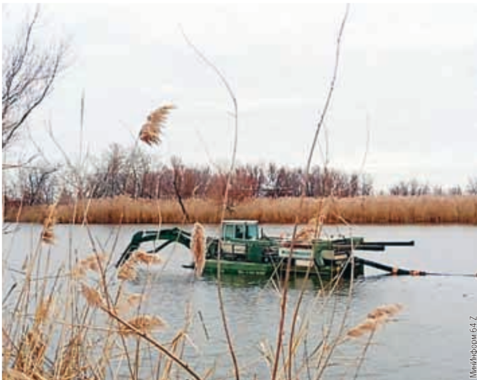
После завершения работ в конце 2024 года общая протяженность расчищенного русла водного объекта составит около 8 км.
