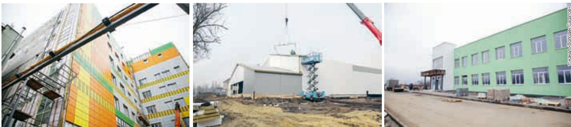
Вячеслав Володин осматривает строящиеся и уже готовые к сдаче объекты.
