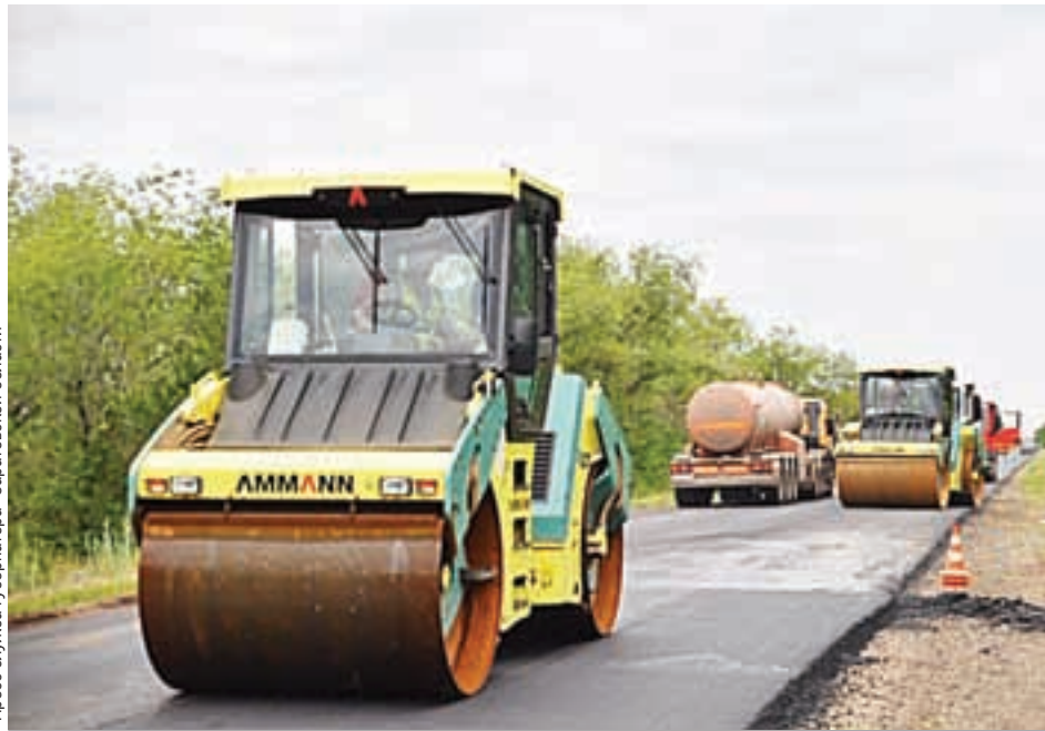
Дорожные работы идут во всех районах Саратовской области.
