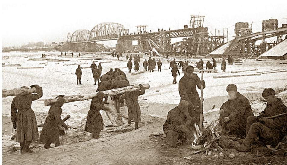
Красноармейцы восстанавливают взорванный железнодорожный мост через реку. Фото: Наталья БОДЕ.
