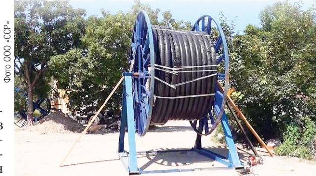
Трубу наматывают на специальную катушку.
