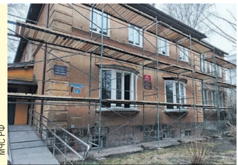
Инженерные сети, фасад - все заменят.
