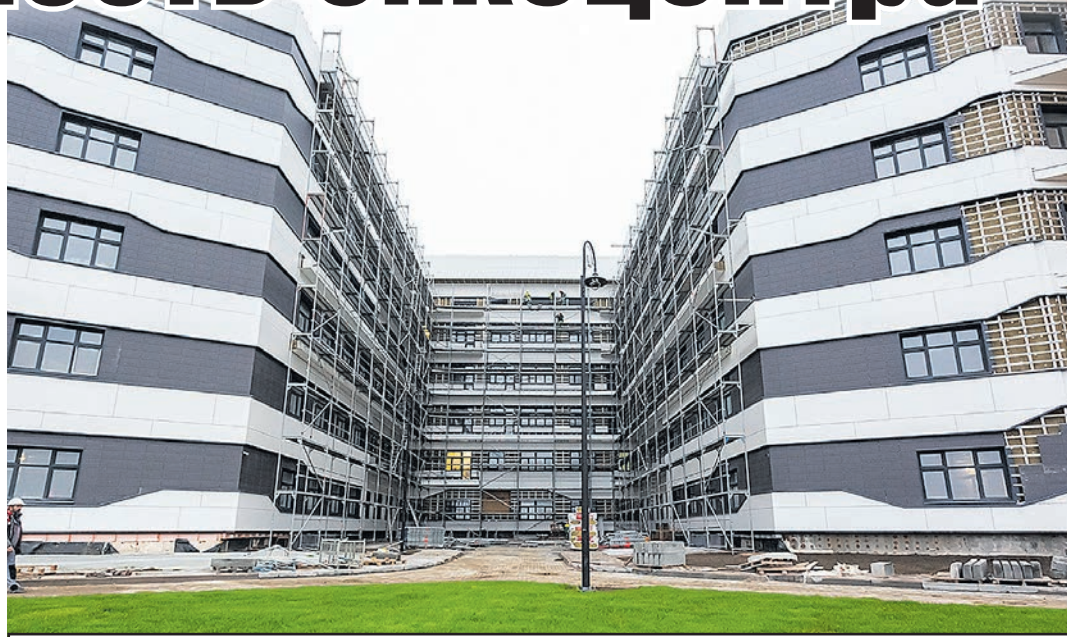
Площадка обеспечена всеми строительными материалами, налажены логистические цепочки их доставки.
