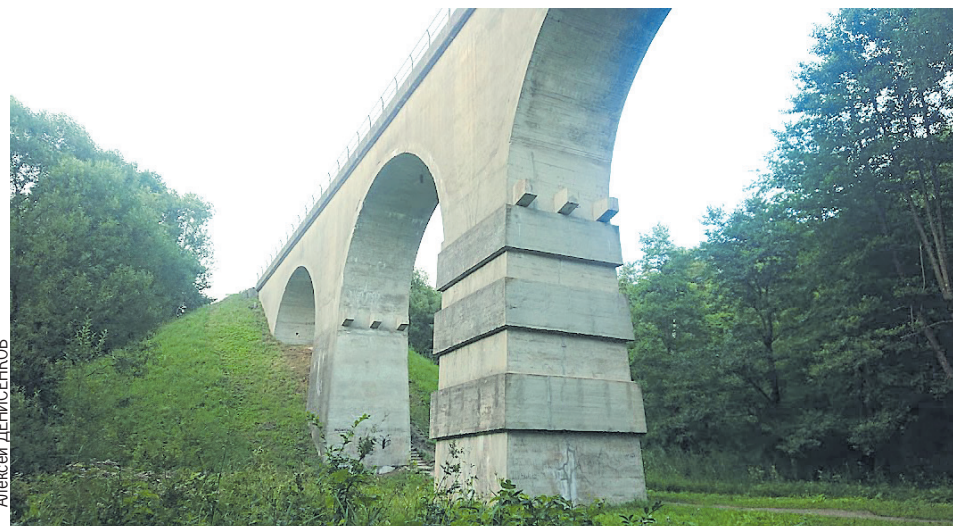
Знаменитый арочный мост в поселке Токаревка напоминает римский акведук.
