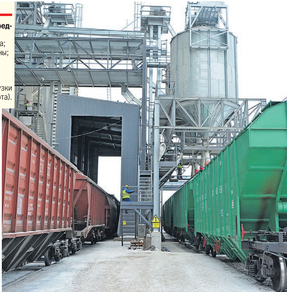
На элеваторе создана универсальная система выгрузки зерна для автомобильного и железнодорожного транспорта.
