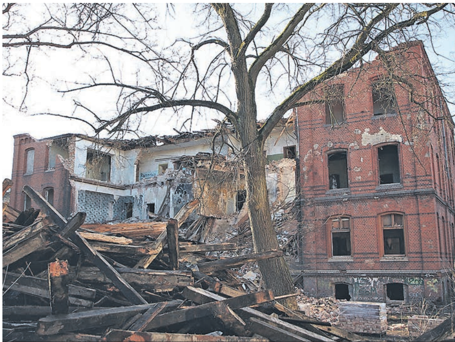
Рабочие успели разрушить около четверти всех конструкций, включая восточный фасад.
