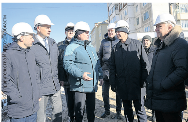
Сенаторы посмотрели, как идет строительство самой крупной школы в Братске.
