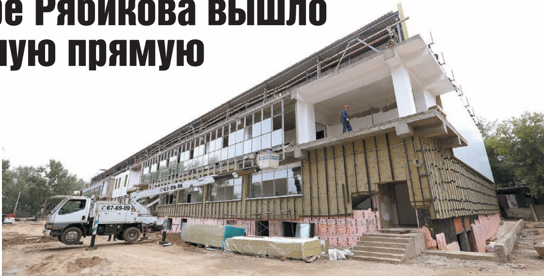
В новом ФОКе откроется 25-метровый бассейн.
