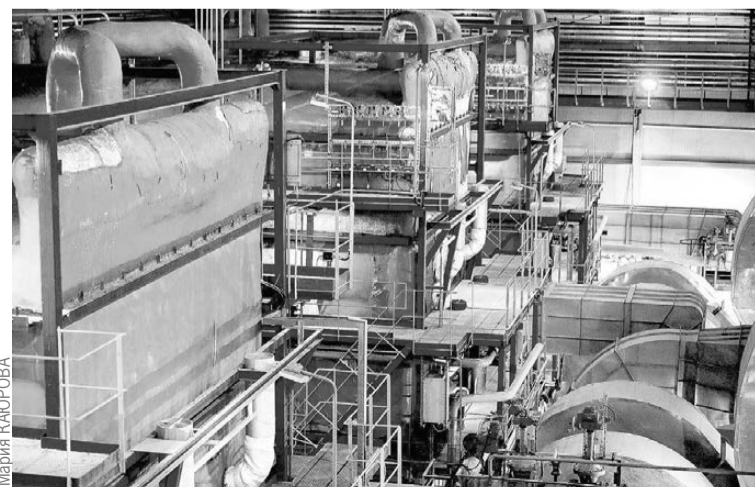
Котлы водогрейные газомазутные используются для теплоснабжения и горячего водоснабжения.
