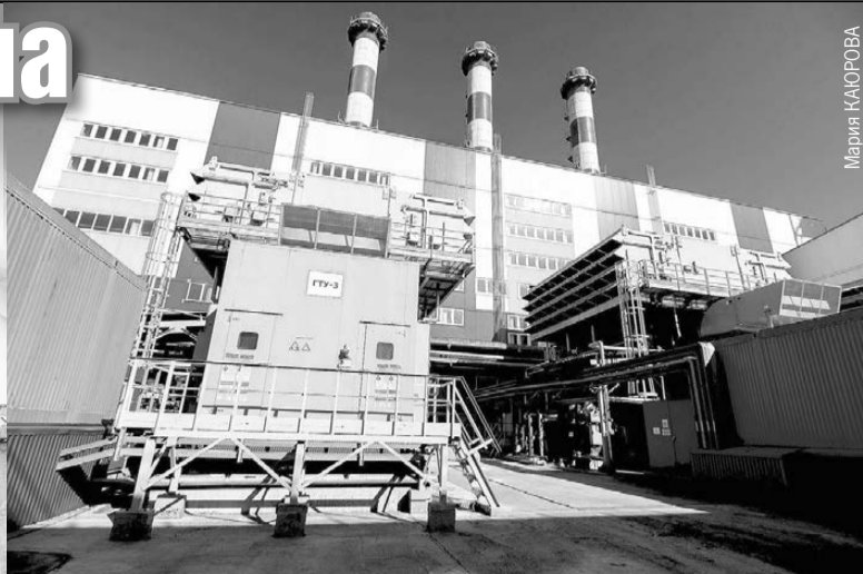
Газотурбинные установки для выработки электрической энергии.
