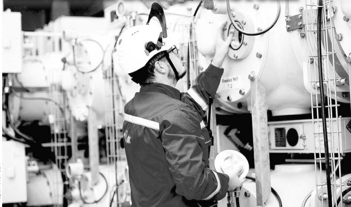
Осмотр контактной системы шинного разъединителя комплектного распределительного элегазового устройства.
