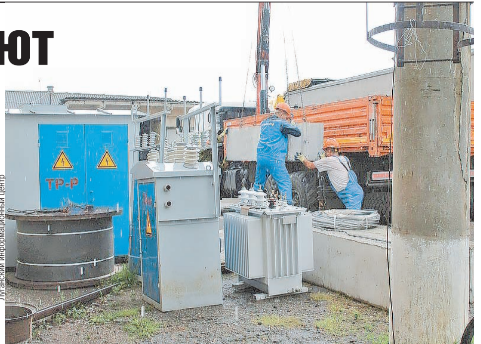
Энергетики с Алтая проводили работы по запуску подстанций в Веселой Горе.
