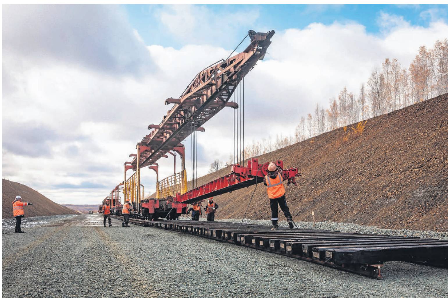
Железнодорожные стройки на востоке множатся со скоростью примерно 1 трлн руб. в квартал ФОТО ИВАНА ШАПОВАЛОВА
