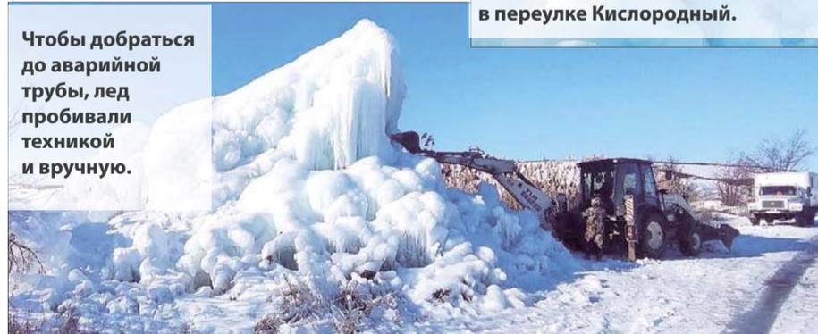
Чтобы добраться до аварийной трубы, лед пробивали техникой и вручную.
