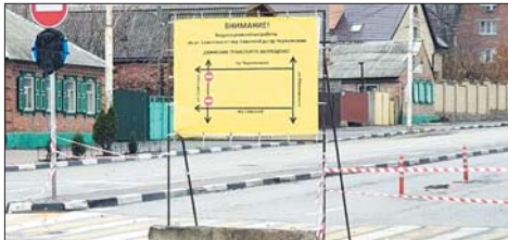
Улице Советской достанутся новые ремонтные работы.
