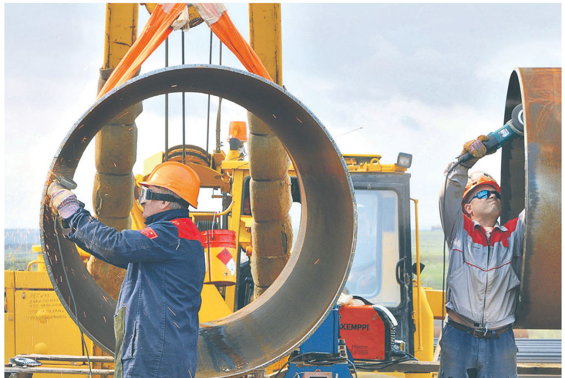
Заказчиком работ по строительству ближних подъездов к морским портам Кавказ и Тамань, а также дороги Новороссийск — Керчь выступило ФКУ «Упрдор «Черноморье». Стоимость работ составит 8,4 млрд руб., дорога должна быть введена в эксплуатацию до конца 2021 года
