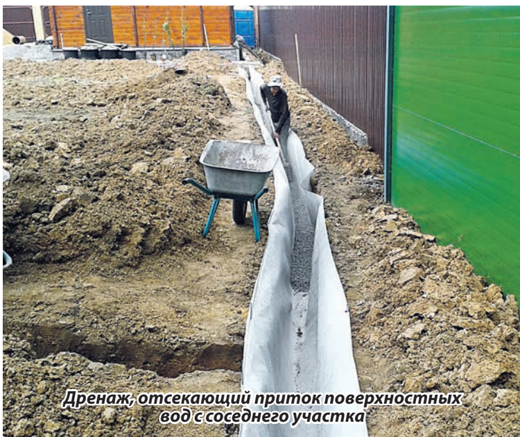
Устройство дренажной сети на участке
