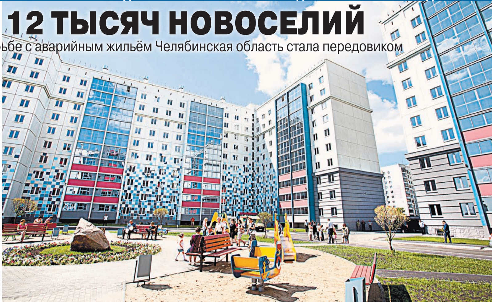
До конца года в Челябинской области вот в такие новостройки переедут жители ещё 58 аварийных домов.
