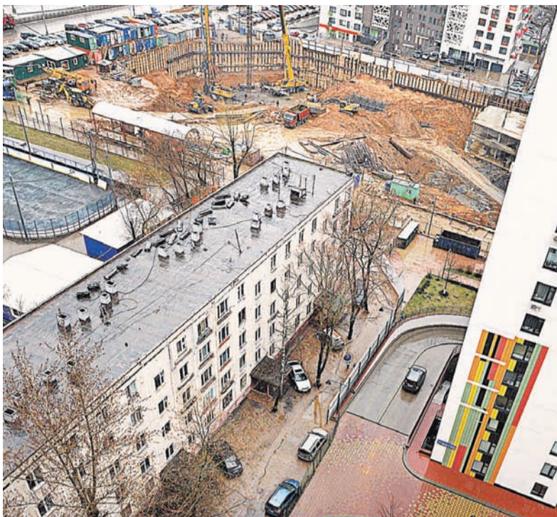
На пяти экспериментальных площадках в районах, где жители скорее хотят переехать из ветхих домов, построят пилотные кварталы.
